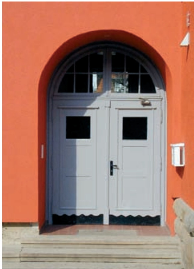
Der Egalisierungsanstrich mit Silikonharzfarbe auf Silikonharzputz gibt dem Rot besondere Leuchtkraft.
