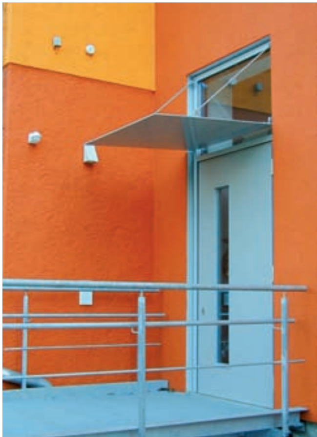
Zurückhaltend grau geben sich die Eingänge der Weilheimer Grundschule, auch der Rollstuhlzugang.
